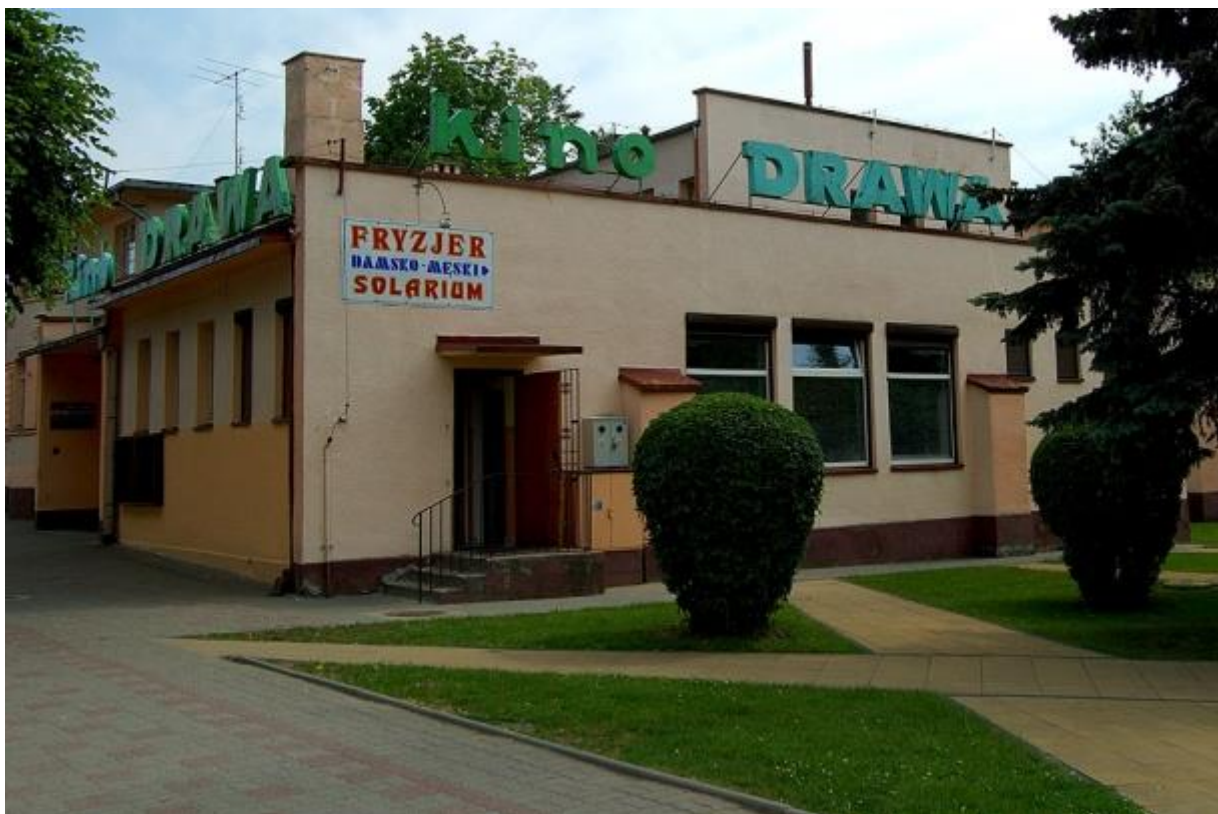
Fot.5 Obiekt kina Drawa przed remontem ( 2007)
