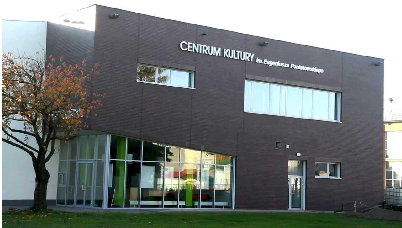
Fot.6 Obiekt kina po przebudowie ( 2012)
