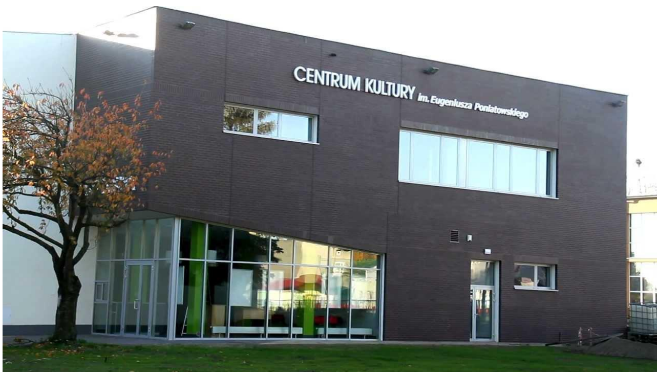
Fot.6 Obiekt kina po przebudowie ( 2012)
