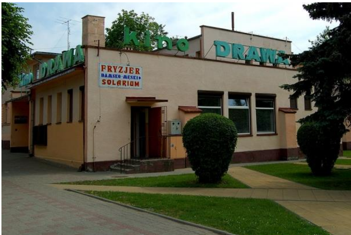
Fot.5 Obiekt kina Drawa przed remontem ( 2007)
