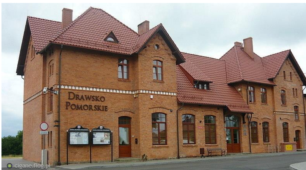
Fot.3 Dworzec miejski po modernizacji
