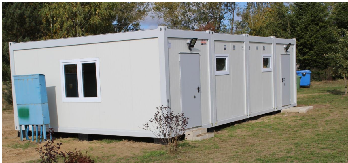
Kontenery na boisku wiejskim w Suliszewie
