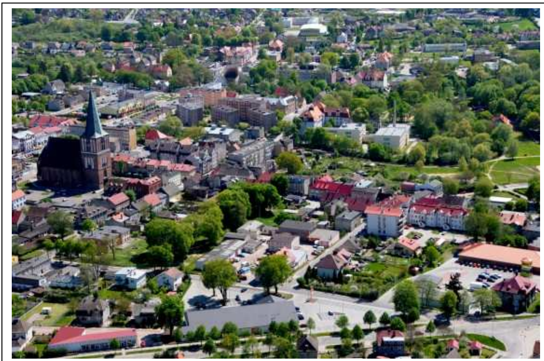
Widok z lotu ptaka – od pñn.-zachodu
