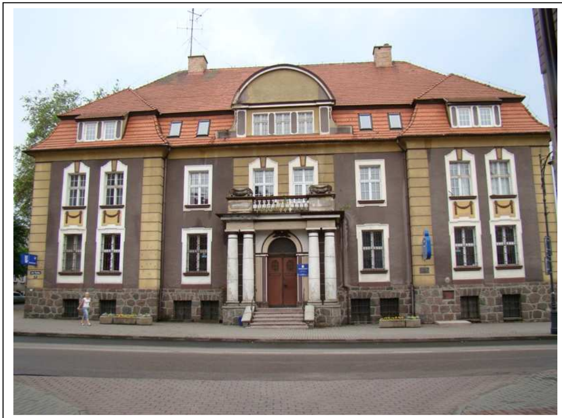
Budynek Powiatowej Kasy Oszczędnościowej, ob. Bank PKO – wg. Gropiusa
