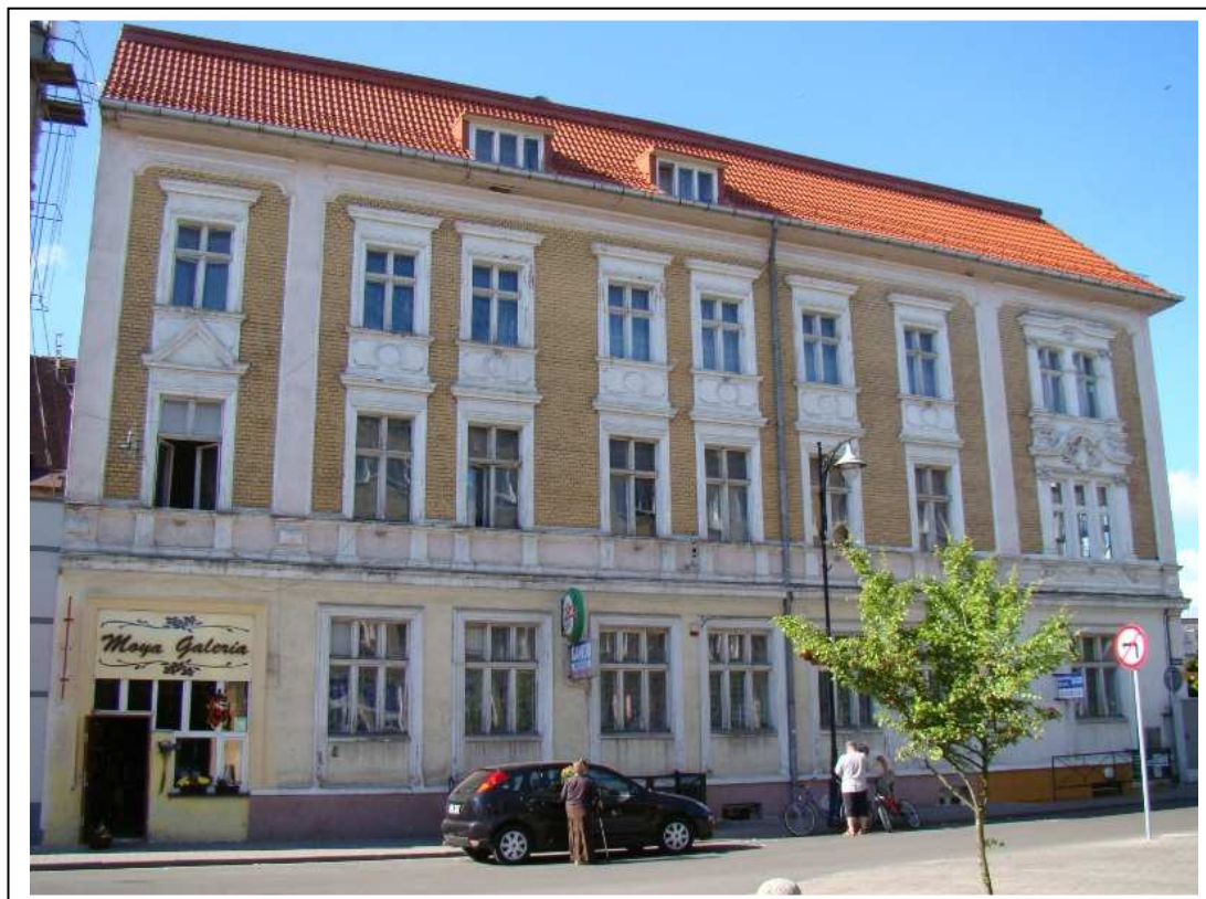
Dom Towarowy, ob. Budynek biurowy – Pl. Konstytucji 7
